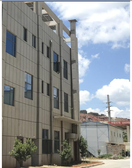
食堂油烟排气筒
