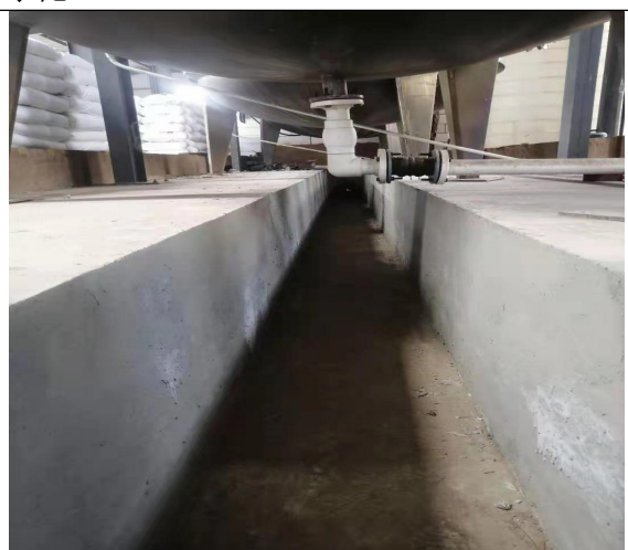
反应釜下方导流沟
