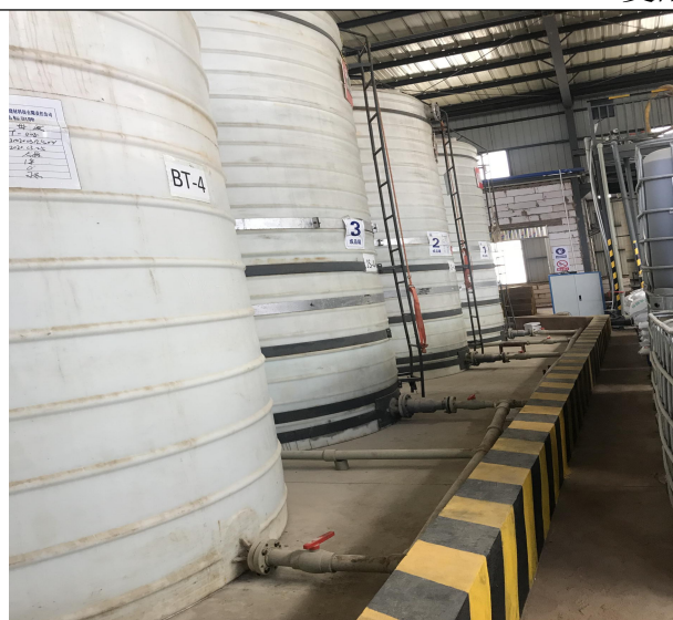
成品储罐区及围堰
