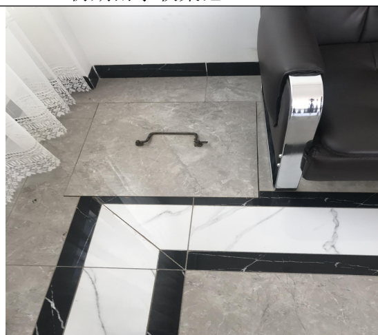
消防水池（200m 3 ，位于食堂餐厅地下，全封闭式）
